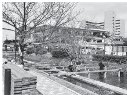
地域連携：崇仁高瀬川保勝会とのウッドデッキ組立
